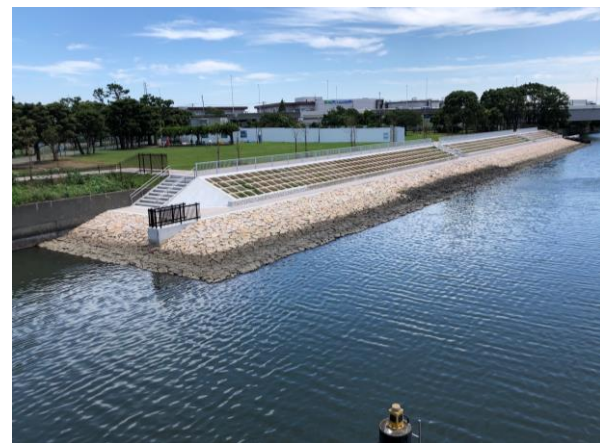
海岸保全施設の整備 (高潮・津波対策)
