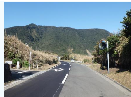
無電柱化整備後（大島町波浮港地区）
