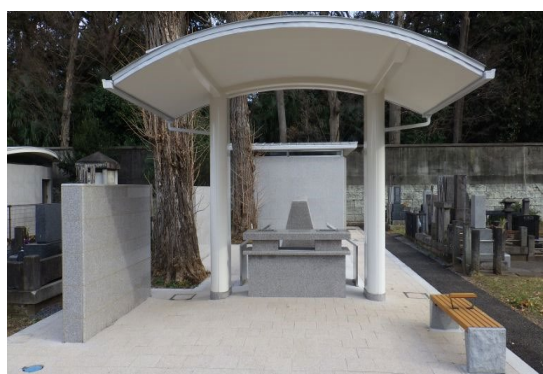
立体埋蔵施設（染井霊園第2区）
