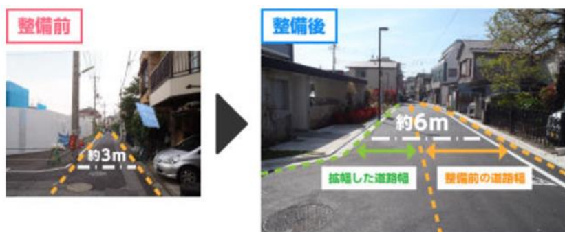
主要生活道路の拡幅と電線地中化の整備例（荒川区荒川）
