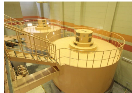
多摩川第三発電所
