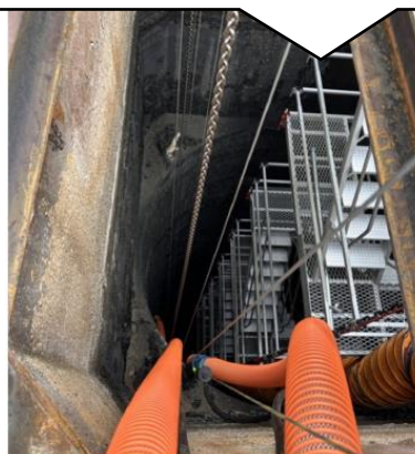
調査のための仮設階段設置
