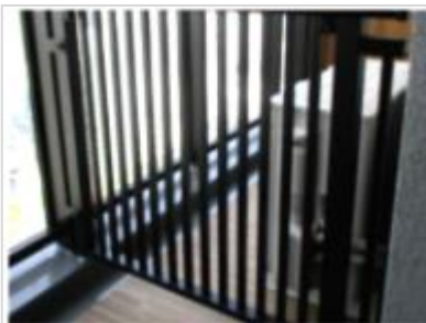
ベランダに置く室外機が足掛かりにならないような柵の設置
