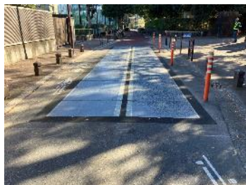
舗装式太陽光パネル設置場所
