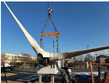
設置工事の様子
