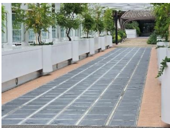
本館・南館7階連絡橋（路面ソーラー400）
