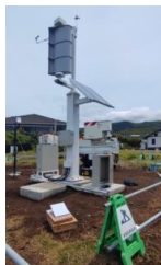
施工写真 (1日で完成)
