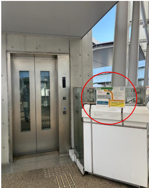
【写真】エレベーター2階出入口付近
