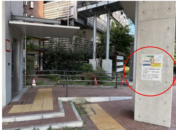
【写真】エレベーター地上出入口付近
