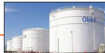
既設タンク(10基)
