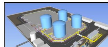
増設タンク (直径25m×高さ23m 容量9,000 k L/基)
