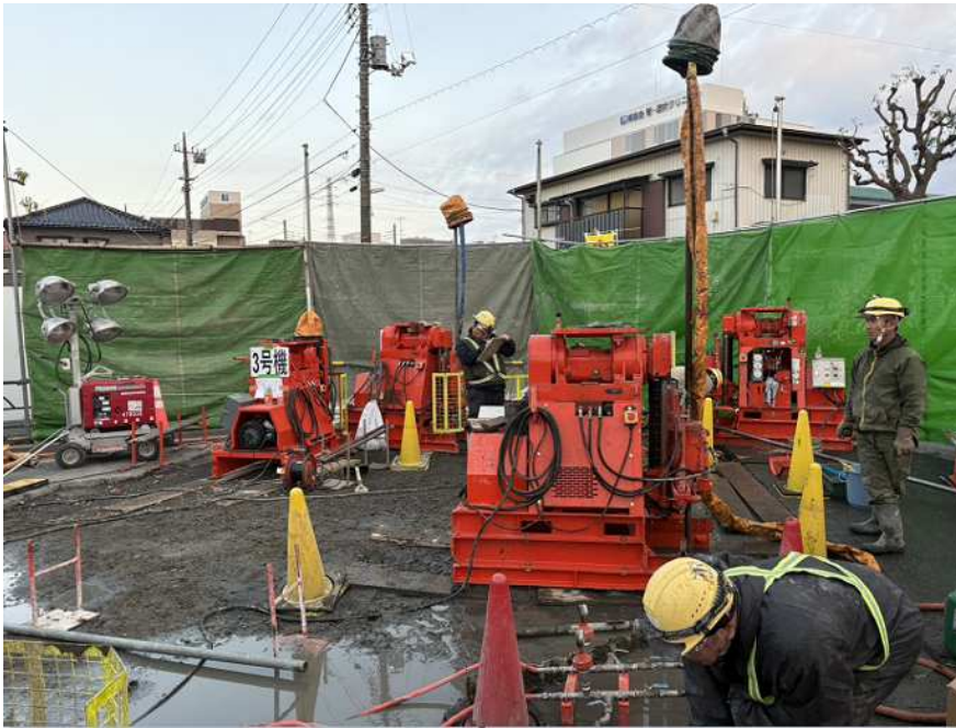
充填材注入状況
