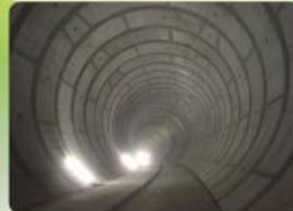
地下調整池の整備
