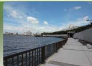
高潮防御施設の整備
