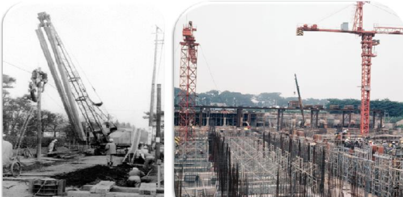
下水道管や水再生センターの建設工事
