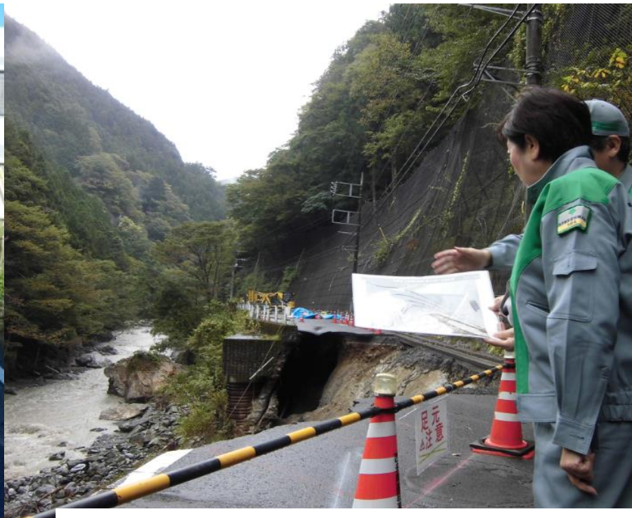
＜奥多摩町＞ 日原川により洗掘された都道204号線
