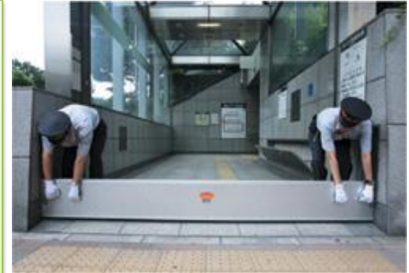
駅出入口の止水板
