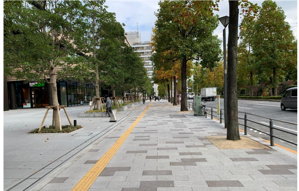
沿道の街並みと調和した整備事例（外堀通り）
