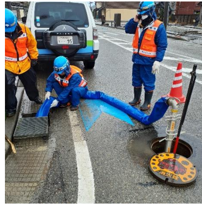
<水道施設の復旧>
