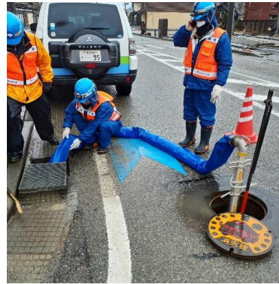
<水道施設の復旧>
