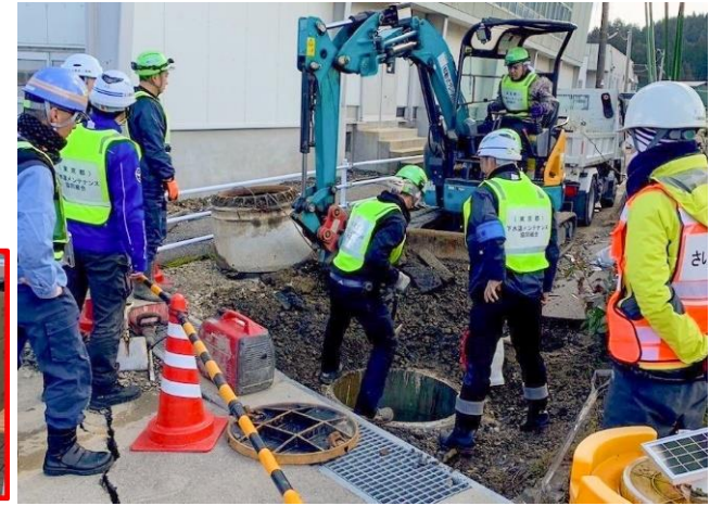
<浮上したマンホールの復旧>
