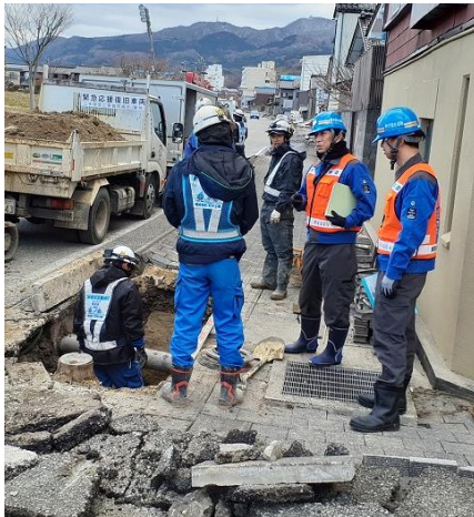
<水道管路の復旧>
