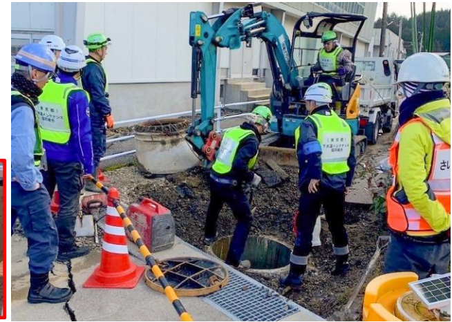
<浮上したマンホールの復旧>
