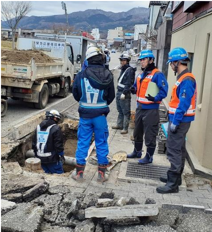
<水道管路の復旧>
