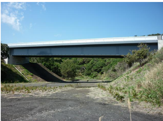
③さかの浜橋 (1期区間)
