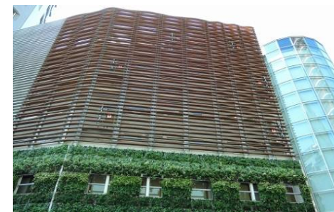
ビルの外壁に木材を利用
