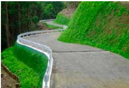
重要な生産基盤である林道
