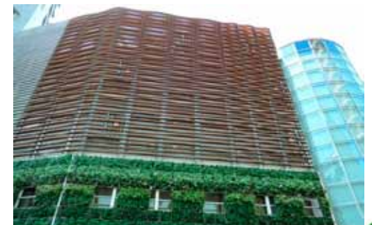
ビルの外壁に木材を利用
