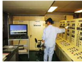
排気口監視モニターチェック
