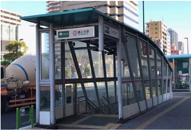
地下鉄駅出入口 都営大江戸線勝どき駅(A3a)
