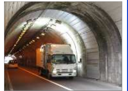
走行型画像計測車による壁面画像計測
