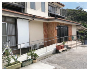
▲入口段差解消 写真提供：新島村式根島 湯ったり宿 肥田文
