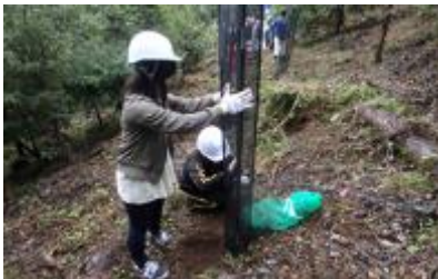
獣害被害防止 ネット設置
