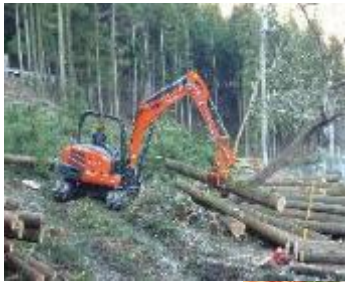
重機による 伐採木整理
