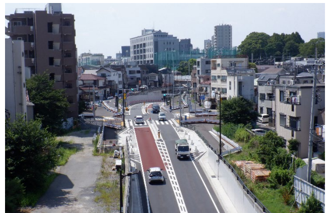
補助第 26 号線（豊町）交通開放後の様子 ＜JR 線交差点付近から平塚橋交差点方向を望む＞
