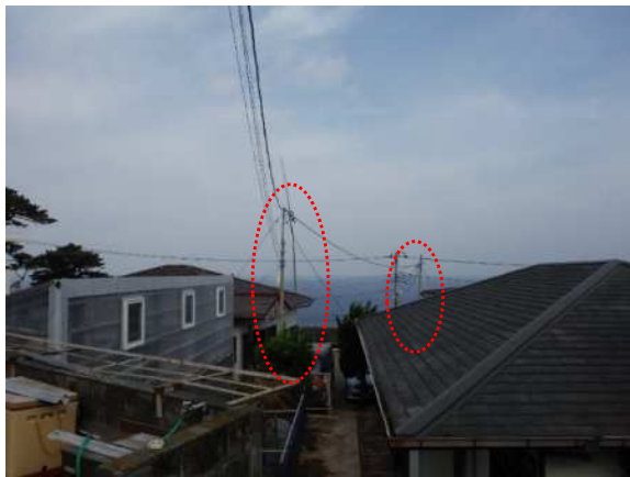
民地内の電柱
