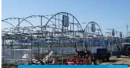
主要骨材の工場組立て現場工期を短縮
